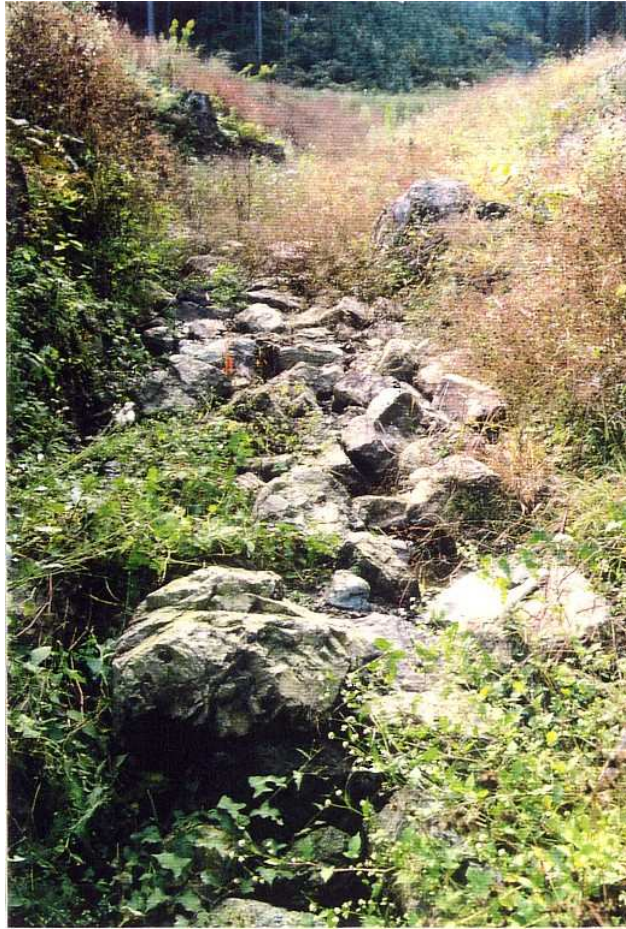
写真-2 自然型水路の状況
