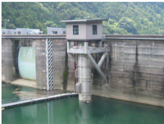
写真-1 河川維持放流取水塔
