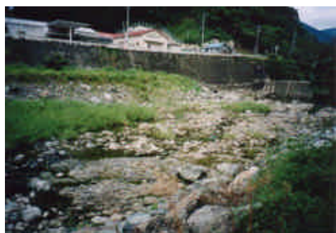
写真 - 2 河川維持放流前状況図 (St. 1)
