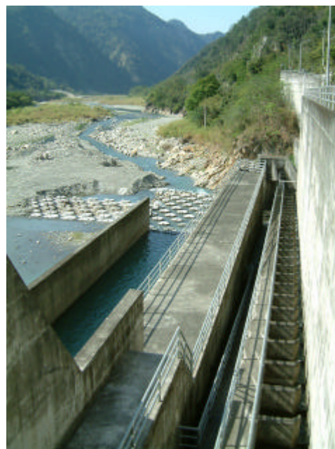
図8 魚道全景(上流より)
