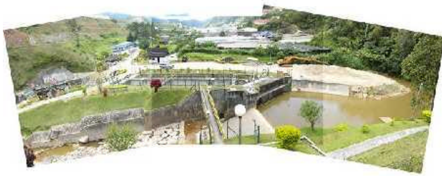
写真1 Telom 取水口の前面にある土砂回収設備（沈砂池）
