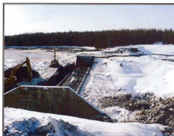
Vue d'ensemble du barrage est. Pose du ballon dans la section de 60m. Le 20-02-2000.
