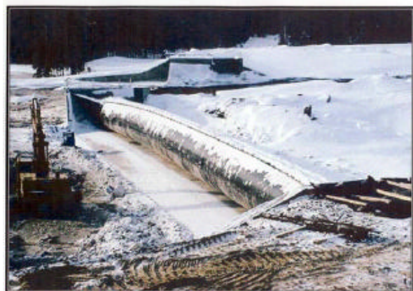
Ballon gonflé, section de 60 mètres au barrage est. - Le 27 Janvier 2000.
