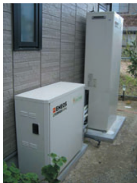
家庭用PEFC システムの設置例 （定置用燃料電池大規模実証事業）
