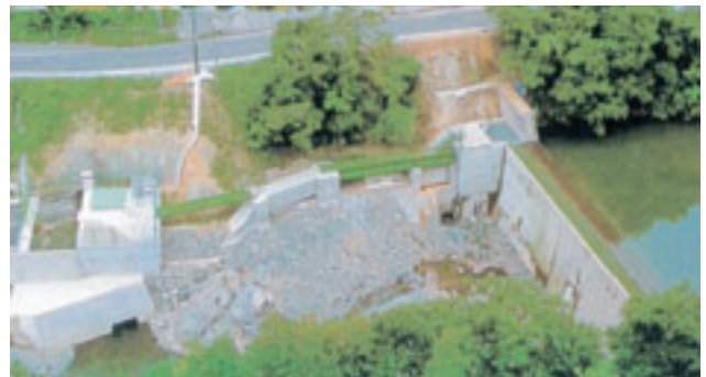
砂防ダム利用の小水力発電所
