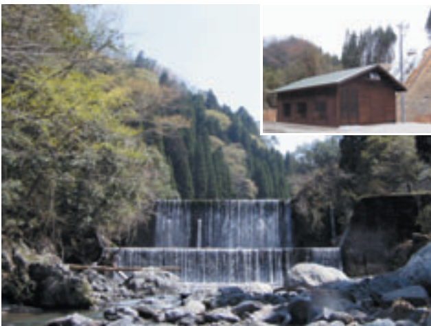
山都町（熊本県）清和発電所（出力190kW）の取水堰（既設砂防堰堤を有効活用）と発電所（右上）で、ハイドロバレー計画を立案し建設されました。
