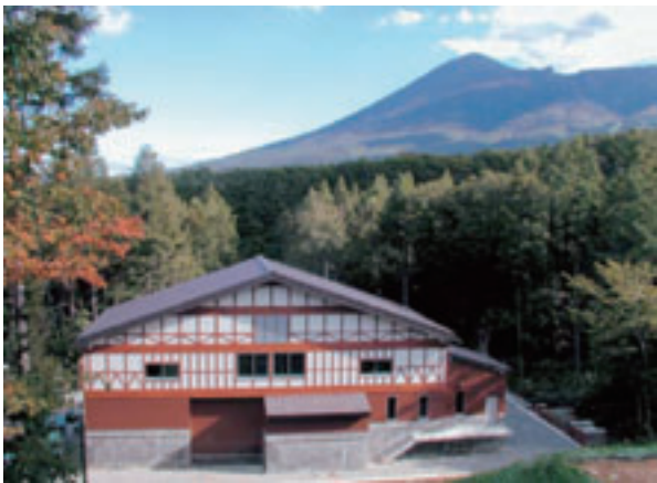
岩手県宮柏台発電所（出力2,700kW）
