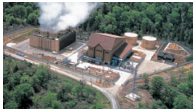
東北電力(株) 澄川地熱発電所 (50MW)
