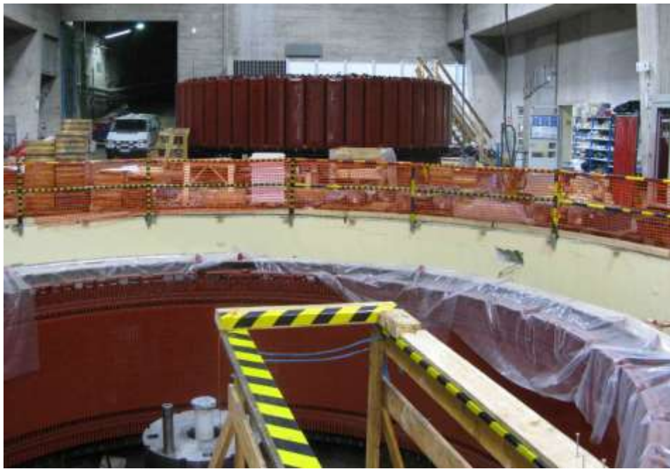
図8 新発電機の固定子と回転子
