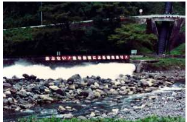
図3 余水放流状況
