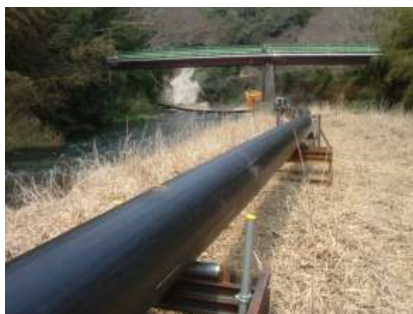
写真-5 管路引き込み状況
