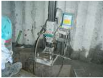
写真-1 コア削孔
