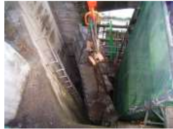
写真-4 ブロック吊り上げ
