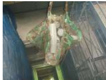
写真-2 削孔コア吊り上げ
