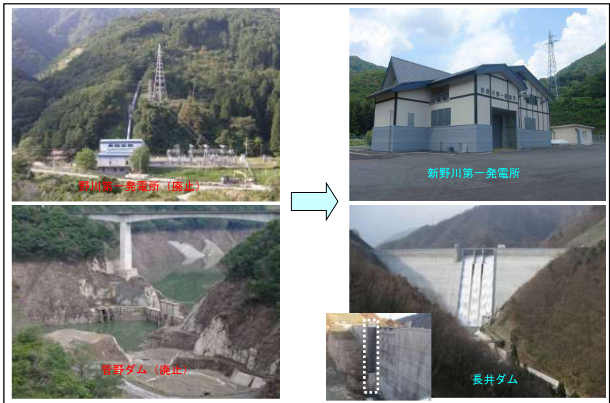
写真1 新旧発電所及びダム
