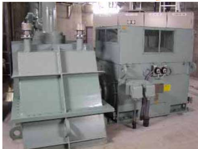
図 1 土室川発電所状況
