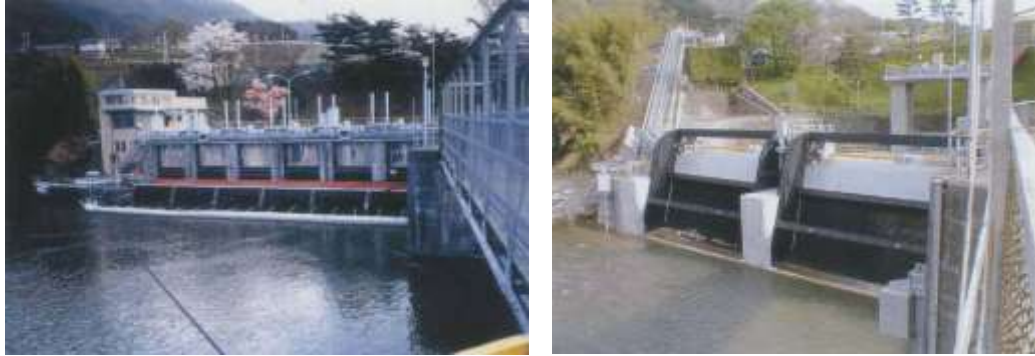
写真1 改修工事前後の取水口
