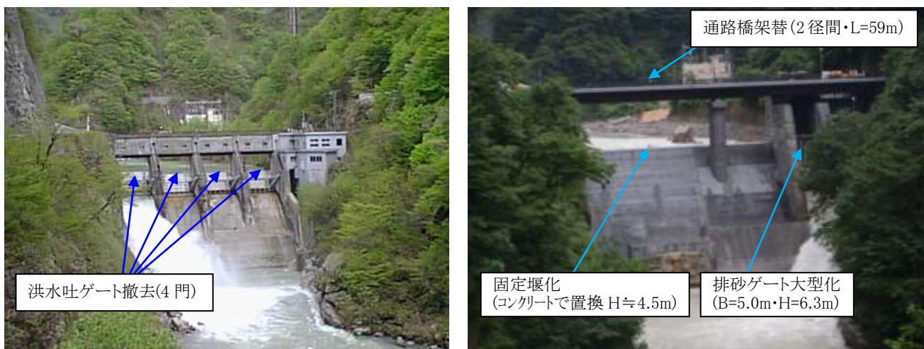
図8 尾口第一ダム改修工事前後のイメージ図
