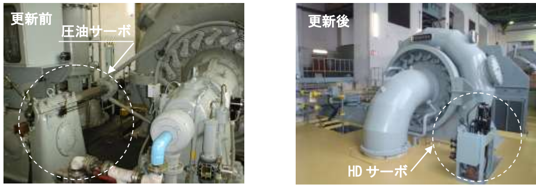
図2 更新前の圧油サーボと更新後のHDサーボ
