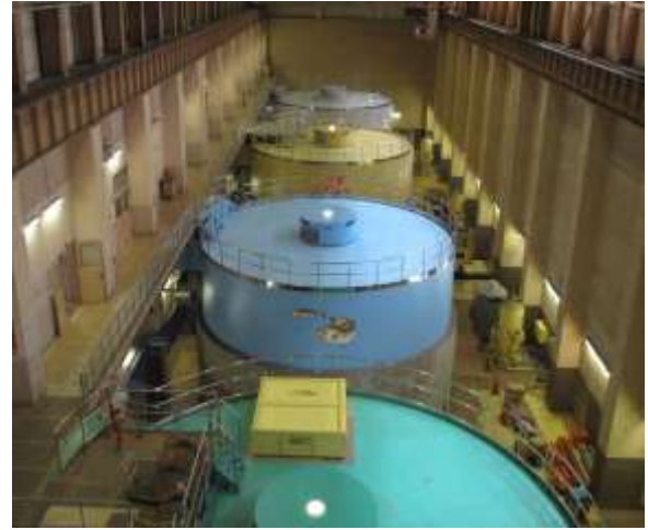
写真-2 田子倉発電所全景（更新後）
