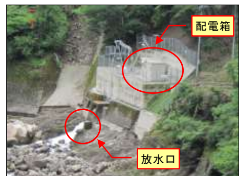
図－8 配電箱設置状況
