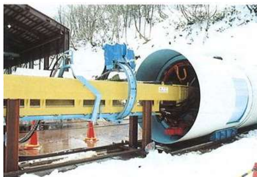
図6 TBM 後方に配置された吹付けロボット
