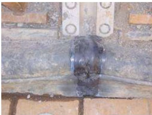
写真12 定着ゴムカバー接続部補修
