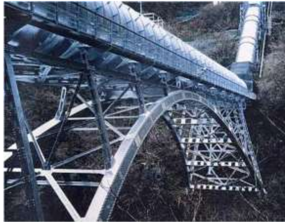
図2 奥泉水力発電所 関の沢水管橋
