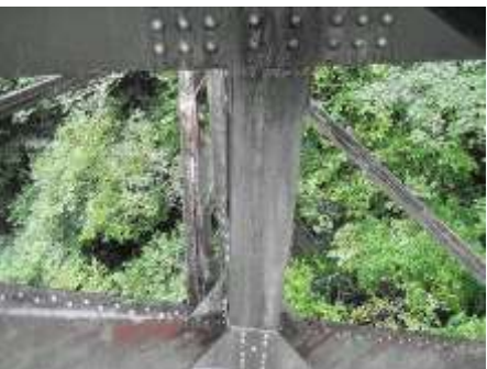
④ 変位制限装置設置
