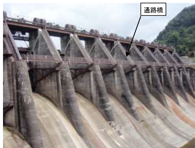
写真4 通路橋設置状況(神二ダム)
