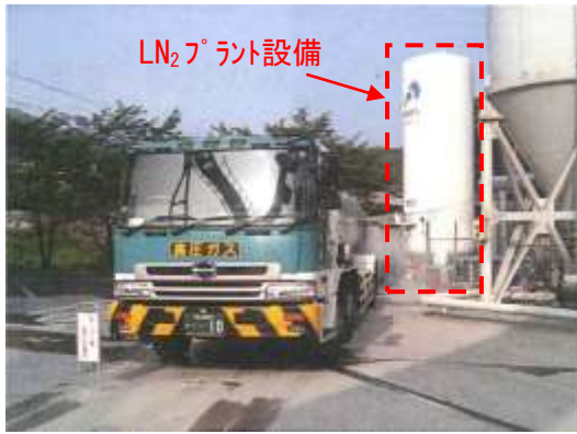
写真2 液化窒素 (LN 2 ) プラント設備設置状況 (レディミクストコンクリート製造工場内)
