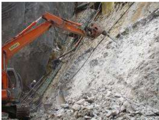
写真1 旧堤体チップング状況
