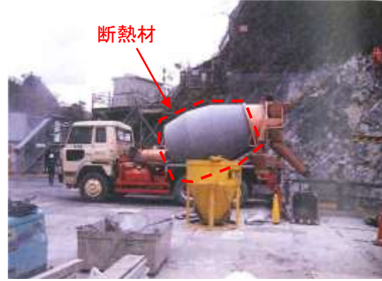
写真3 断熱材を取り付けたミキサー車
