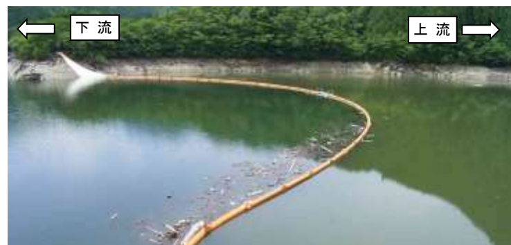
写真1 濁水対策フェンス設置状況
