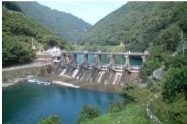
写真1 取水堰損壊前の状況写真
