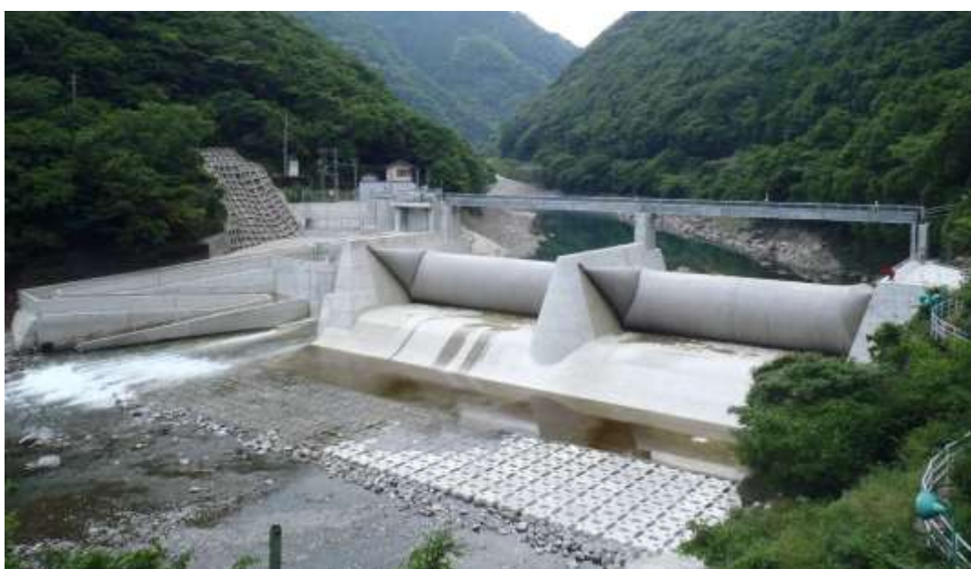
写真3 取水堰復旧後の状況写真
