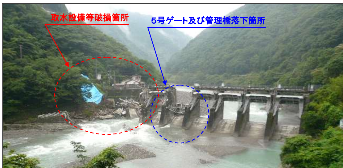
写真2 取水堰損壊時の状況写真（遠景）
