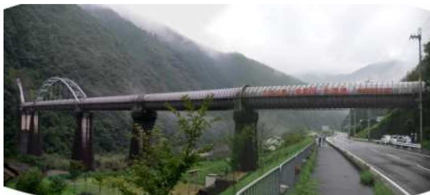
写真-1 十津川第一発電所 野尻水路橋全景
