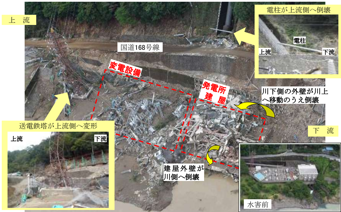
図—2 長殿発電所の被災状況
