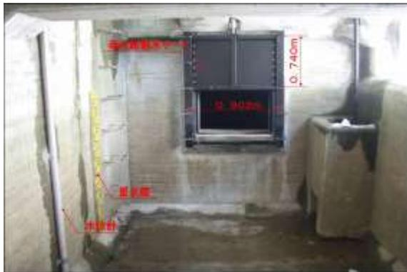
図—6 導水路制水ゲート他設置状況
