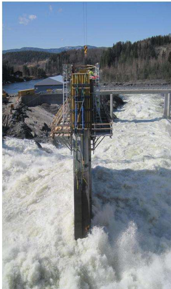
洪水中のダムセンターピラー建設 (2011 年)
