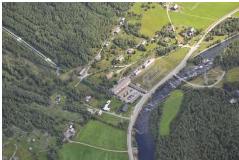
Hol 1 発電所の水圧鉄管、屋外発電所及び開閉所
