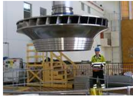
取り付け中の新しいランナー
