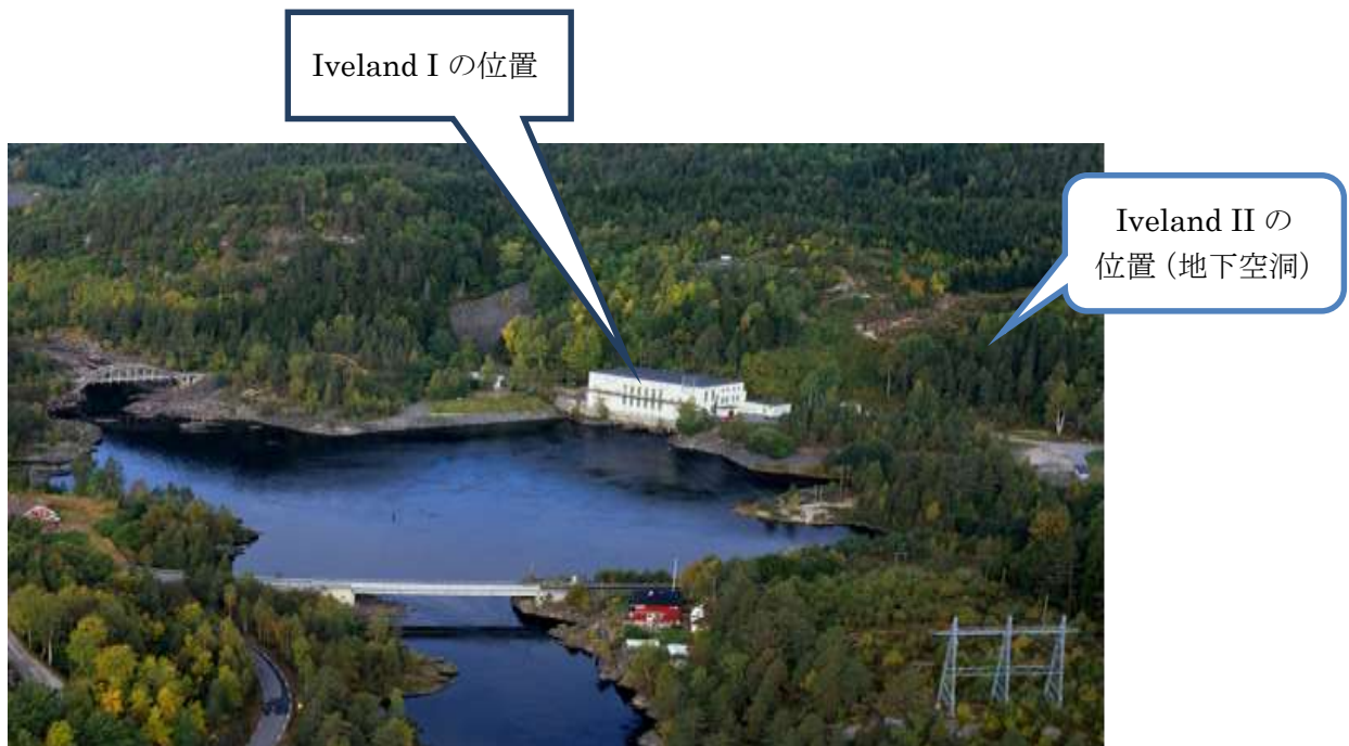
既設発電所の写真
