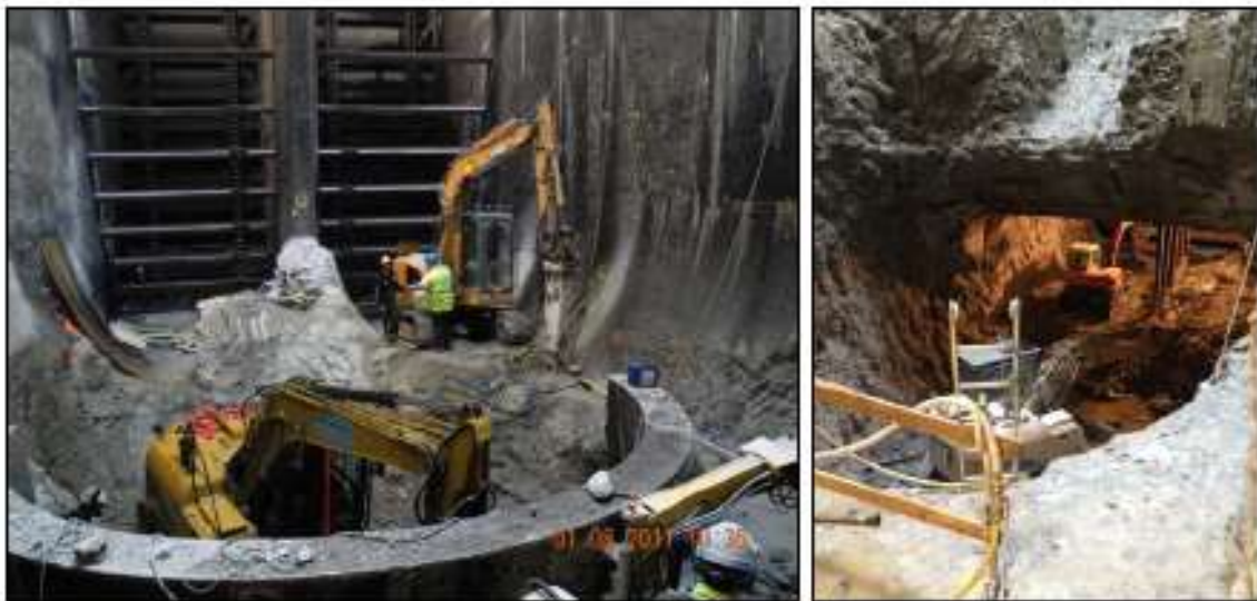
図9 取水槽及びドラフトチューブのコンクリート及び岩石の破碎
