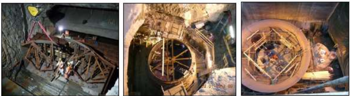
図 11 ドラフトチューブ及び入口コーンの組み立て
