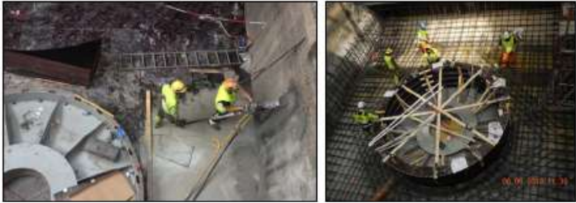
図 12 ボルト据付及び発電機床コンクリート打設の準備
