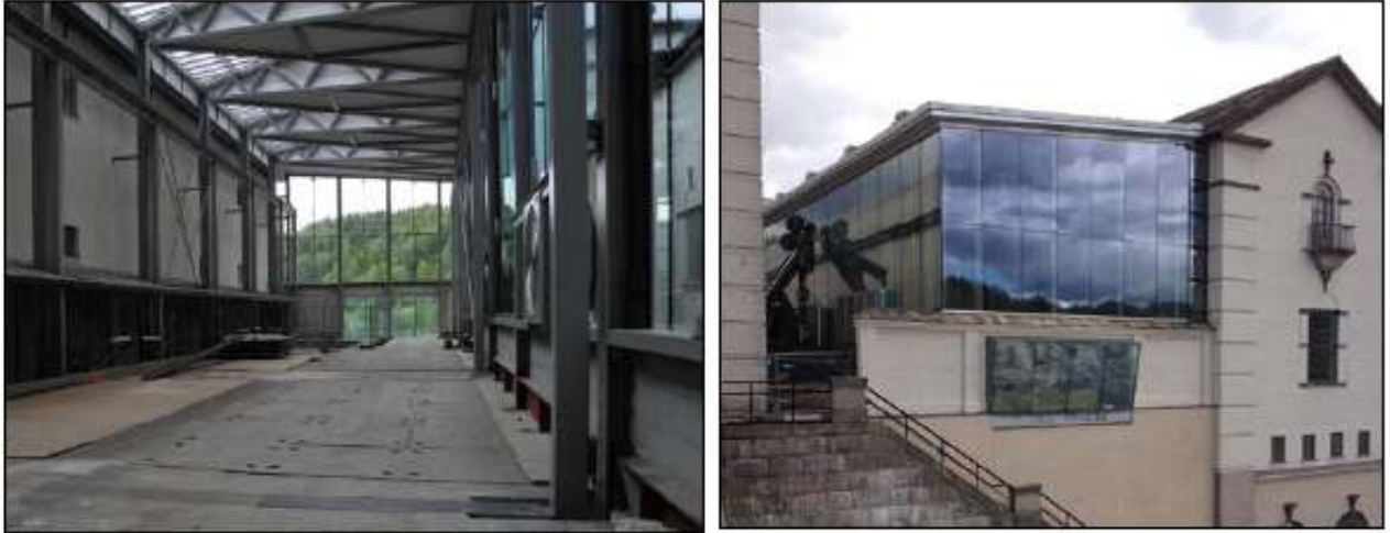
図7 Rånåsfoss IIIの新たな発電所建屋の内観及び外観
