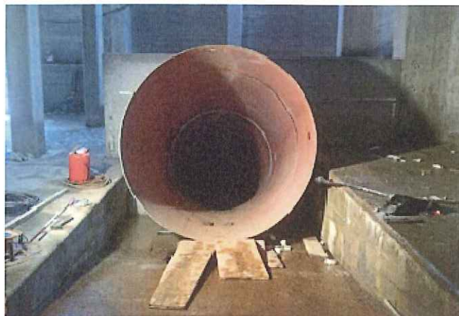
水路への接続（左）および既存の上部貯水池の圧力立坑の延長（右）
