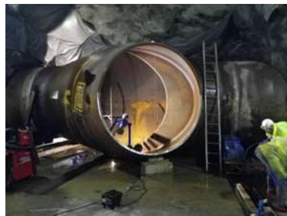
既存の圧力立坑のT字路
