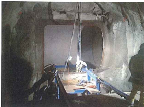
水路への接続（左）および既存の上部貯水池の圧力立坑の延長（右）
