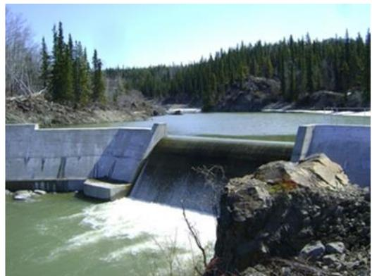
写真-1 小規模重力ダム(堰)<sup>[1]</sup>
