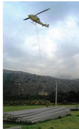
写真-4 ヘリコプターによる送電線建設<sup>[2]</sup>
