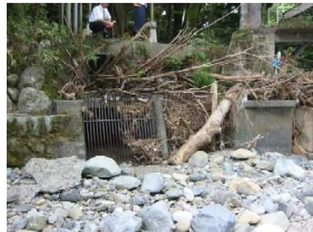
写真-1 取水ダム・取水口(改修前)
