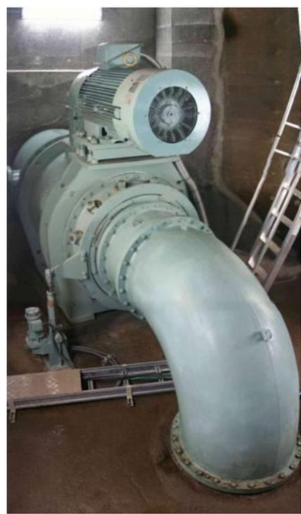
写真-8 水車・発電機(改修後)
