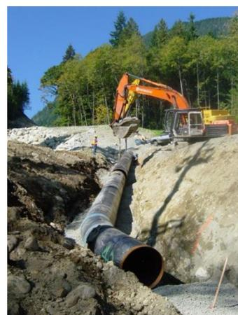
写真-3 埋設型水圧管路<sup>[2]</sup>
