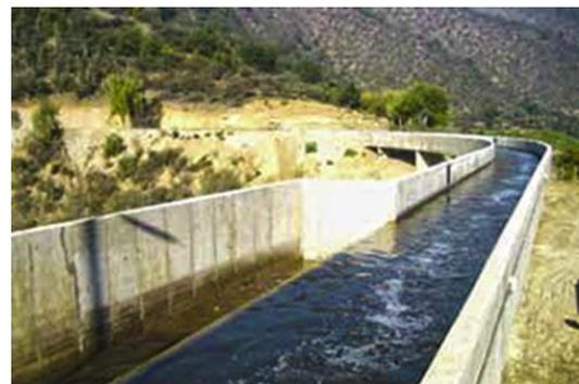
写真-2 灌漑用水路からの取水設備<sup>[2]</sup>
