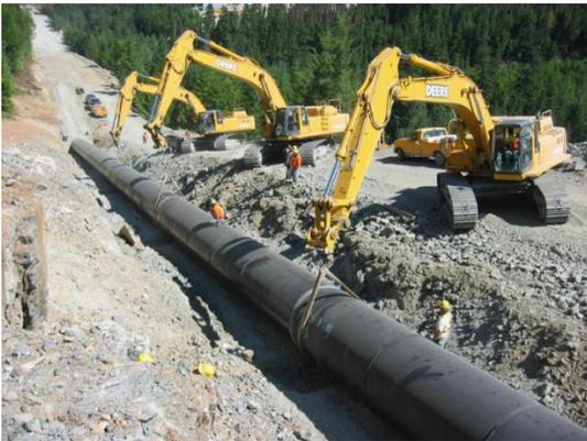
写真-3 埋設水圧鉄管<sup>[2]</sup>
