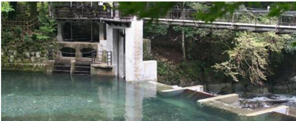
写真-2 取水ダム・取水口(改修後)
