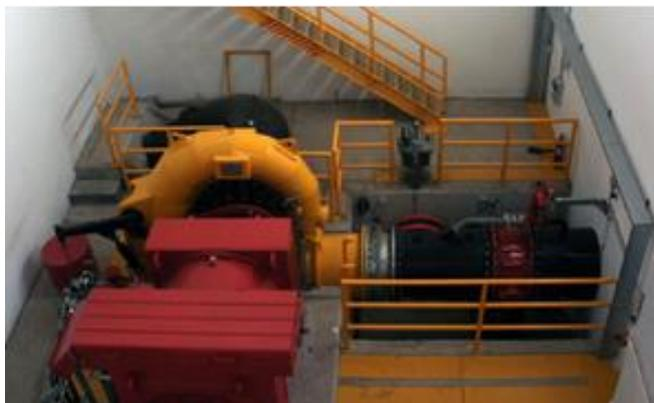
写真-3 所内水車発電機<sup>[2]</sup>
