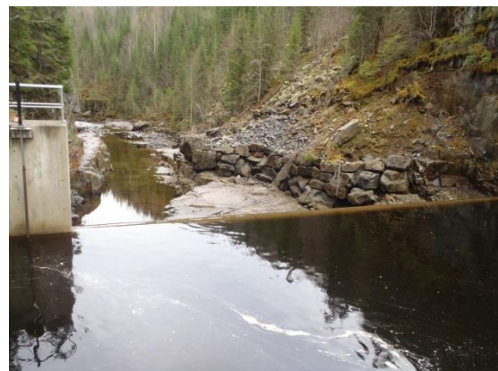
写真-2 取水堰 (Storfallett 発電所放水庭)
