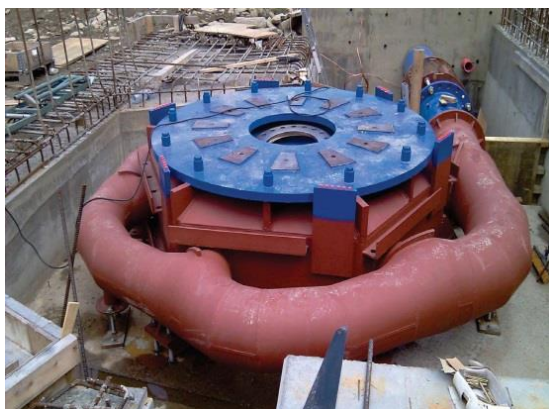
写真-4 水車ケーシング (建設中)
