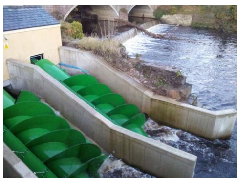
Torrs ハイドロ発電所と同じ Goyt 川の下流、約 8km にある Otterspool 堰に設置された出力 60kW のマンチェスターでの最初のコミュニティー発電所。2012 年に運転開始。
