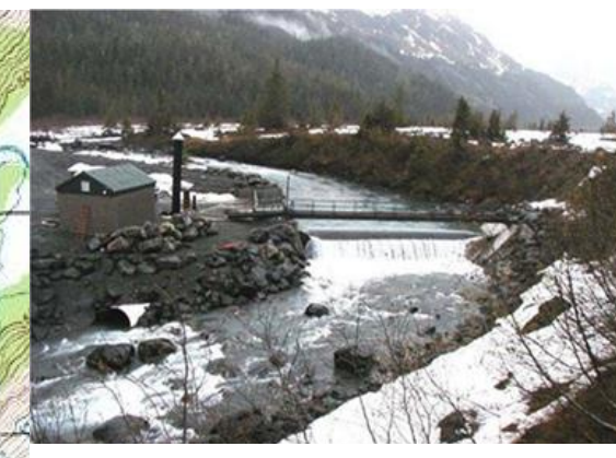
Power Creek 発電所取水設備
