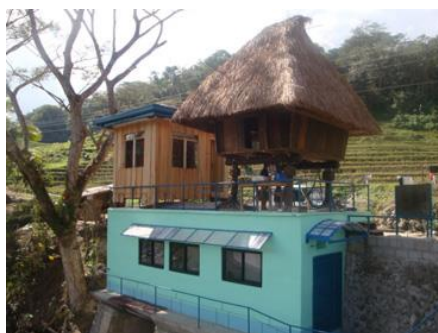
写真-6 発電所建屋
