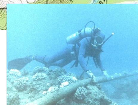
海中送電線点検
