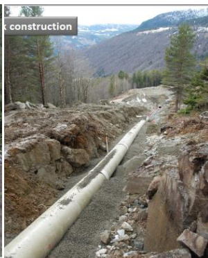
写真-2 GRP 水圧鉄管敷設工事
