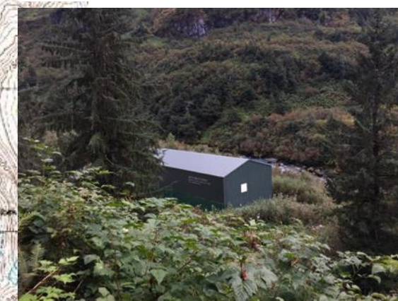
Power Creek 発電所建屋
