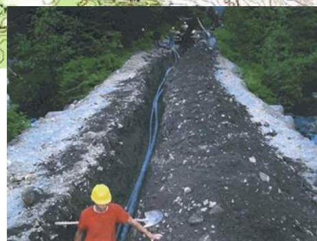
送電線の埋設工事中
