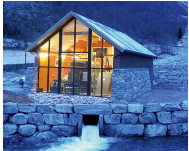
写真-2 発電所建屋
