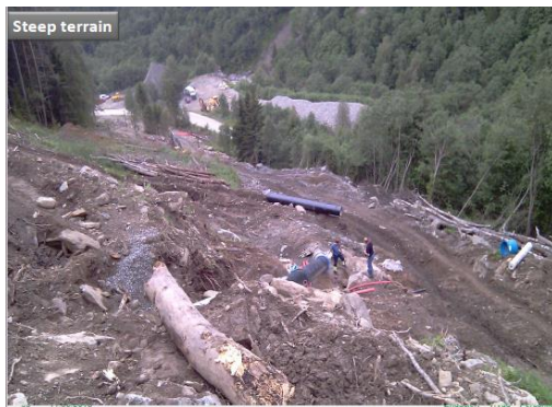
写真-2 GRP 水圧鉄管敷設工事
