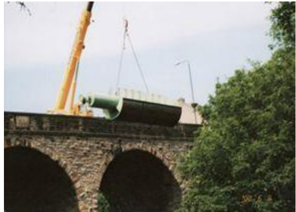
写真-3 Union Road 橋からの水車吊り下げ搬入 [2]
