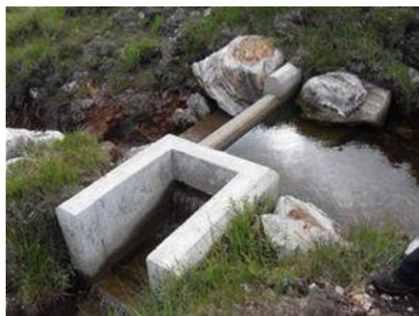
写真-2 支流取水堰
