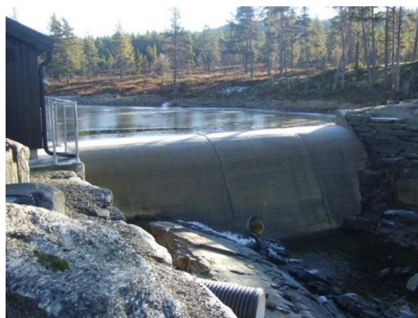
写真-1 取水ダム
