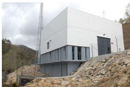
写真-3 発電所建屋 [2]
