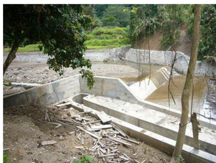
写真-2 取水ダム
