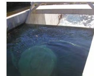
図4 VLH DN 4500型 水車発電機運転中(上流側から見た写真)
