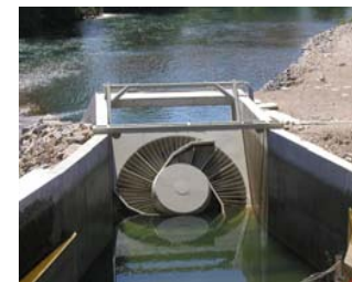
図3 VLH DN 4500型 水車発電機据付(上流側から見た写真)
