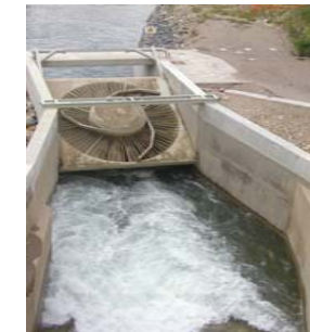
図5 VLH DN 4500型 水車発電機メンテナンス位置保持状態
