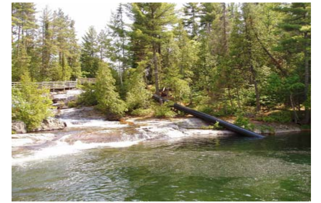
写真2 水車下流側配管/放水庭への設置状況
