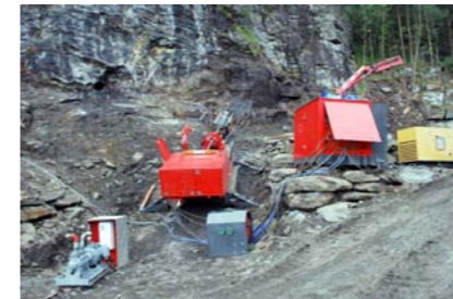
次世代掘削機 NDL700HR型
