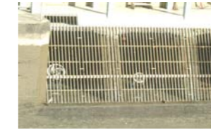
写真-3 設置状況(スクリーン前面側)
