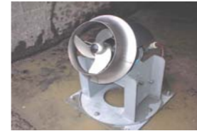
写真-1 水中ミキサー設置状況
