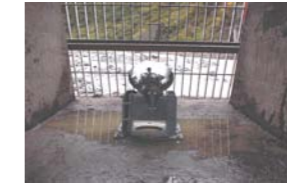
写真-2 設置状況(スクリーン背面側)
