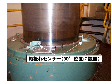
写真2 水車軸振れセンサー取り付け状態
