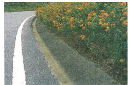
図.5 傾斜型排水側溝
