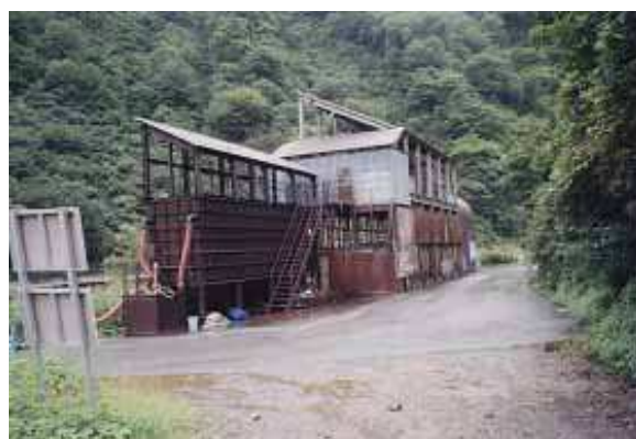
写真－4 濁水処理設備 (処理能力 200 m 3 /h)
