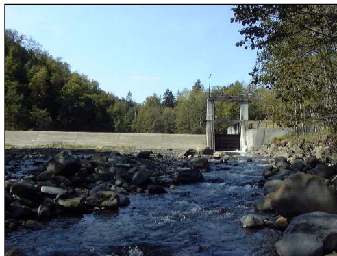
写真-4 シイ十勝取水設備の維持流量 (2002.9)
