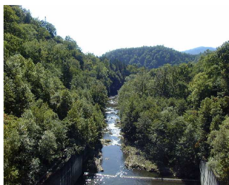
写真-3 富村ダム下流の流況 (2002.9)
