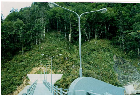
写真－7 富村ダム右岸側の跡地緑化箇所 (1978.9)
