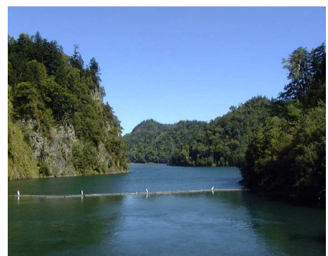
写真－6 富村調整池の状況 (2002.9)
