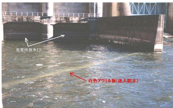
写真-2 発電所放水口迷入防止装置
