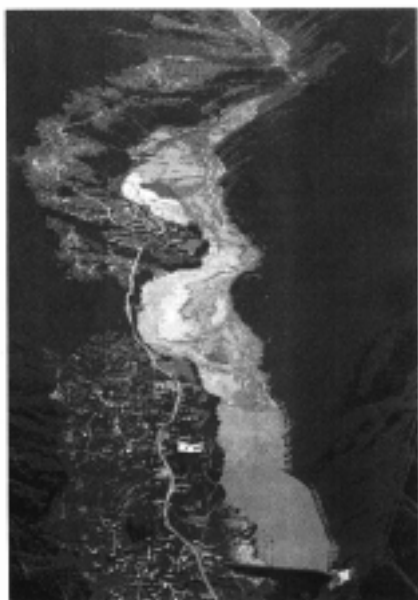
写真 - 1 美和ダム堆砂状況 (平成元年 3月)
