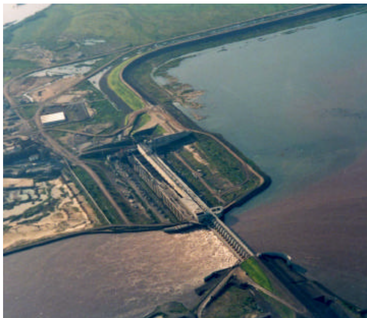
図- 2： 建設中のダムと主洪水吐（手前）および発電所掘削
