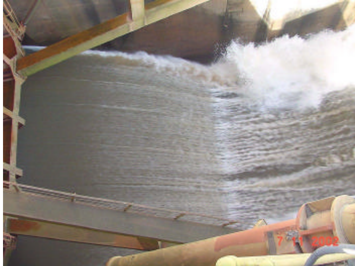
図- 6b : A aCu洪水吐 : ゲート部分開放でのデフレクター流下状況
