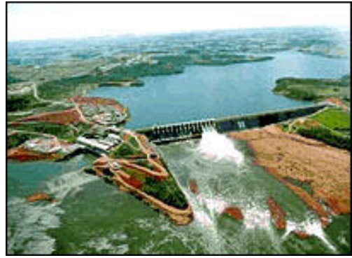
Salto Caxias 水力発電所
