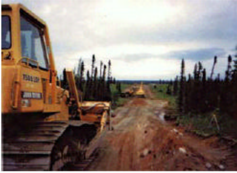
図7 Vincelotteアクセス道路の建設
