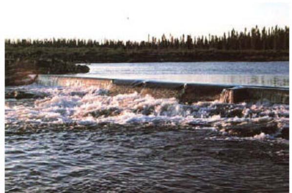
図17 コンクリート堰 (Vincelotte/I)
