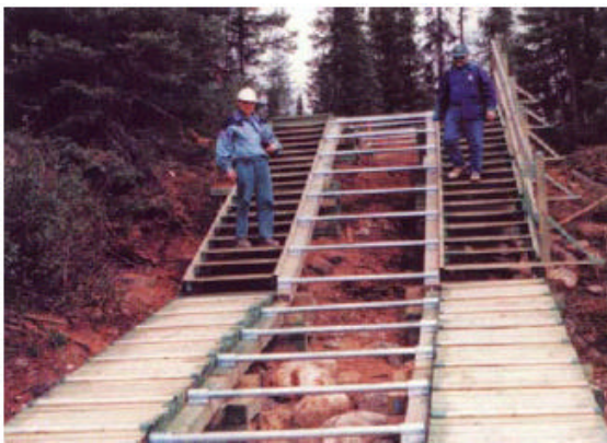
図9 牽引設備をもつ陸上輸送施設 (Vincelotte川)
