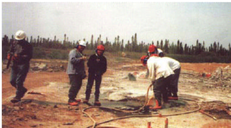
図6 Vincelotte川に堰を建設するCree族作業員
