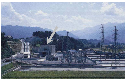
写真-7 黒東第二発電所 周辺状況
