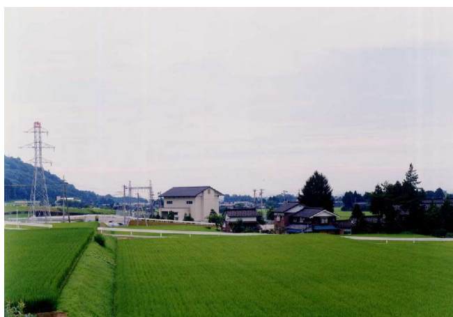
写真-2 黒西第一発電所 周辺状況
