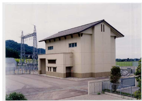
写真-3 黒西第一発電所
