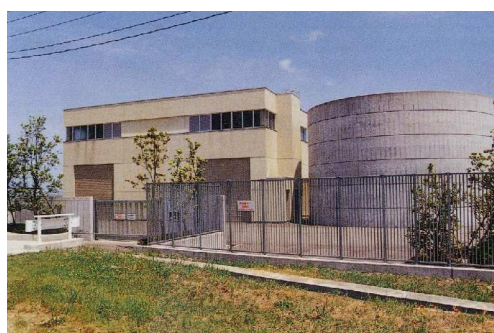
写真-5 黒西第三発電所
