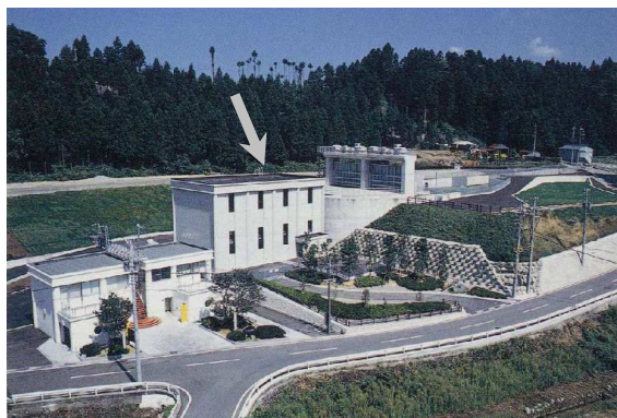
写真-6 黒東第一発電所 周辺状況
