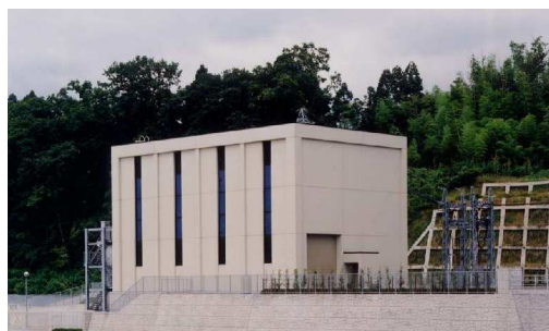
写真-8 黒東第二発電所
