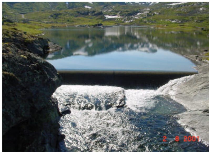
写真6 コンクリートを利用して作られた堰
