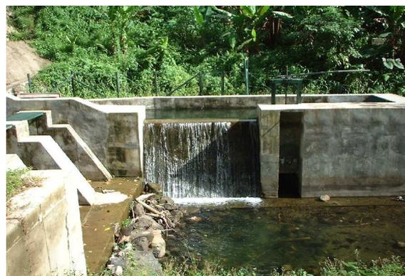
Mahagnao マイクロ水力実証プロジェクトは、信頼性のあるかつ精度の高いデータを用いて設計され、特に水文データは発電使用水量、土木構造物、水車発電機容量を設計するために用いられた。収集データの慎重な精査に基づき、計画地点の条件から、流込み式の発電形式が選定され、それが最適かつ経済性に優れていた。われわれはまた、本プロジェクト(Mahagnao Lake)が国立公園内に位置しており、フィリピン法の下、必要な許可の取得に際して、追加的費用および時間を伴った。
